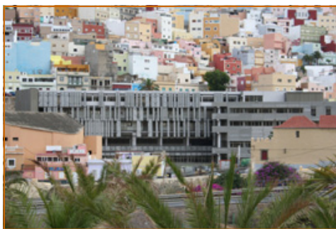
Edificio administrativo construido por la ULPGC con los fondos RIC
